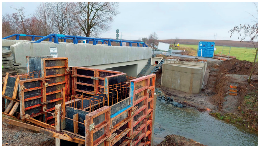
Stavba lávky pro cyklostezku Hněvotín-Lutín
