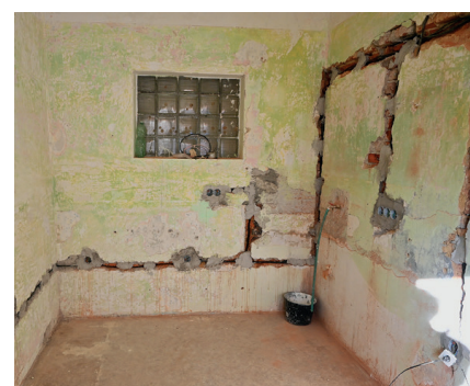
Rekonstrukce domu s pečovatelskou službou
