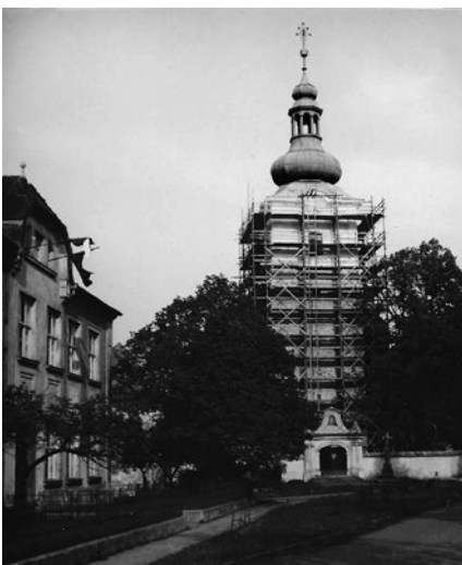
Kostel obklopený lešením
