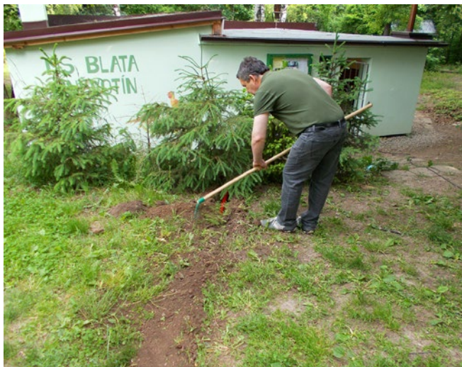
Předseda MS MUDr. Pavel Andrš zasypává přívodní elektrický kabel.
