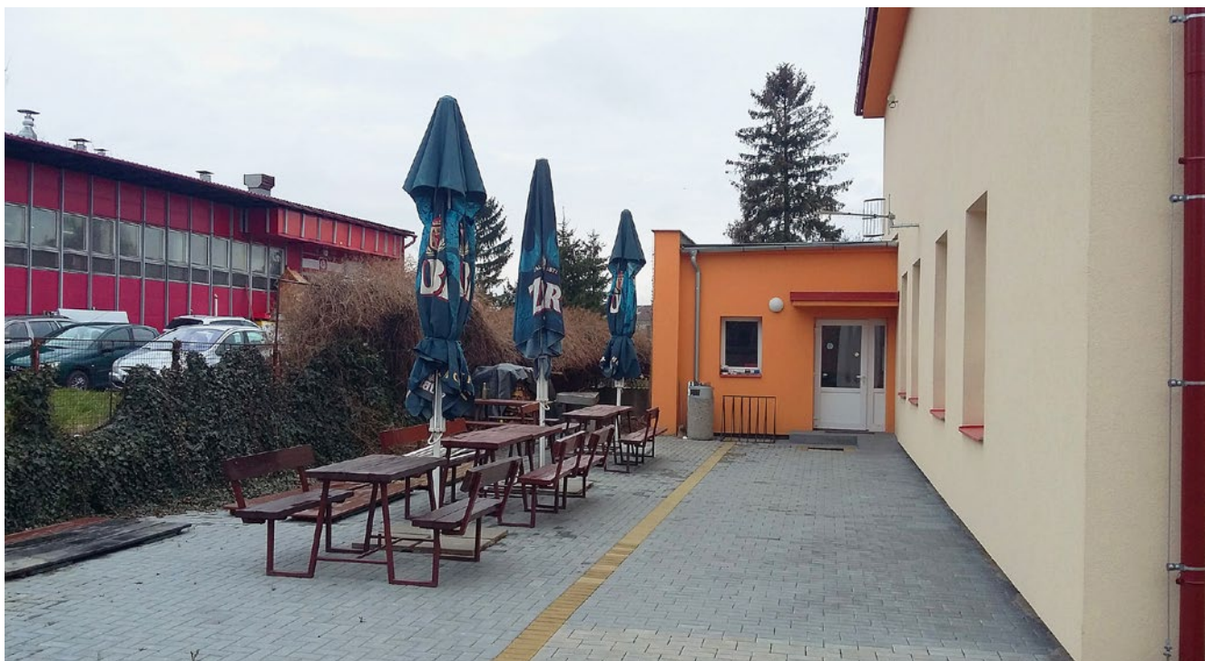
Na zahrádce u restaurace Za Kulturákem obec připravuje zastřešení a instalaci osvětlení.
