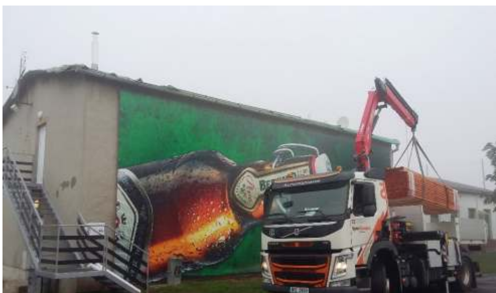
I při finanční nejistotě začala firma S-pro, s.r.o. na vlastní náklady s montáží nové střešní krytiny s tím, že faktura bude zaplácena v odloženém termínu.
