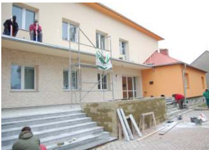
Dokončeno je zateplení přední části Kulturního domu včetně klempířských oprav a izolací. Dokončuje se oprava balkónu a schodiště. Úpravy prostranství před budovou chceme ještě realizovat po přeložení vedení nízkého napětí a veřejného osvětlení.
