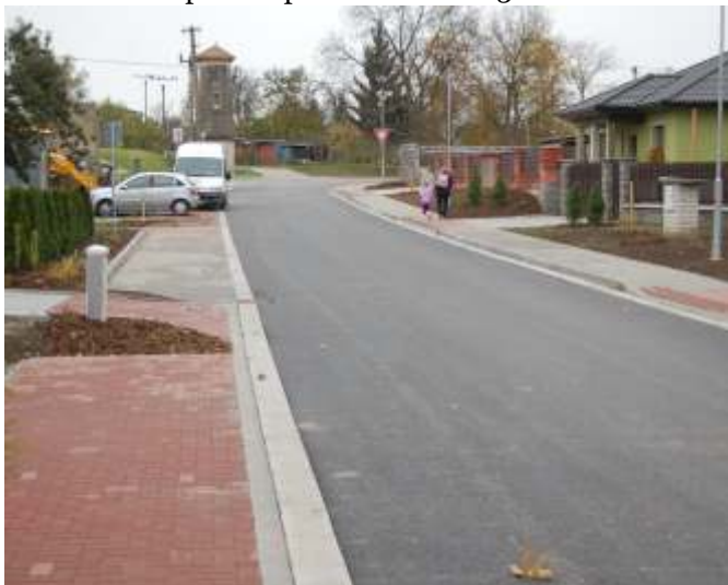
V polovině října jsme dokončili stavební práce ne revitalizaci Malého Válkova a výstavbě parkoviště v ulici Hřbitovní. V současné době jsou už dokončeny i zahradnické úpravy. Máme tak v pořádku další část obce.
