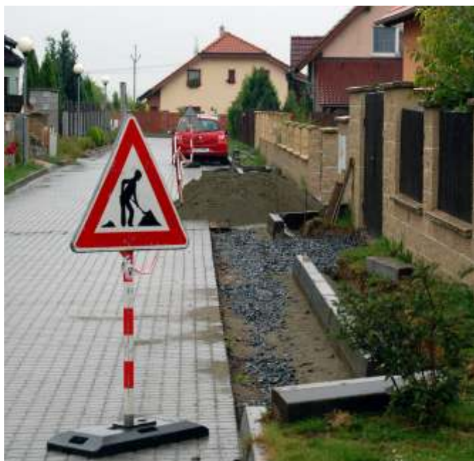
Rozšíření prostoru pro vyhýbání vozidel v současnosti probíhá v ulici „Pod skalou“. Akci realizují zaměstnanci obce a bude ukončena v první polovině července.
