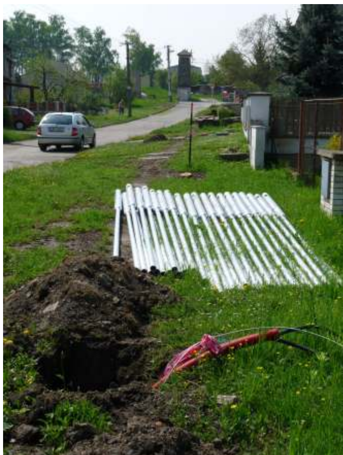
Snímek zachycuje stav prací na veřejném osvětlení v části obce Malý Váلكov.
